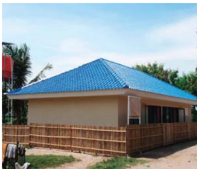
分娩設備を備えた診療所の建設支援 2009 - 2011年までに10箇所建設
