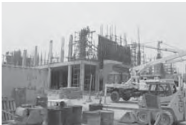
建設中のバスラ小児病院(2006年4月)
