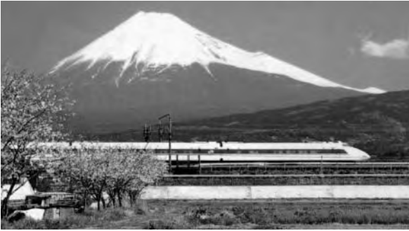
世界銀行融資により 1964 年に完成した東海道新幹線
