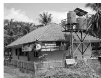
新設した深井戸
